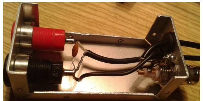
Figura 4.5: Immagine della scatola di alluminio in cui sono stati realizzati i collegamenti del sistema.
